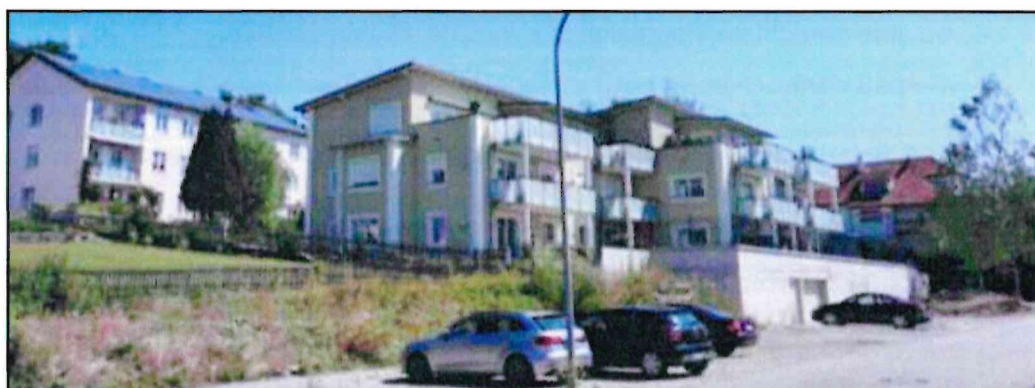
Abb. 9 im Jahr 2022 errichtetes 10-Familienhaus (Birkenweg 12) mit blechgedecktem Pultdach vor Mehrfamilienhaus (Birkenweg 10) mit Satteldach und Solaranlage; Quelle: PV; Aufgenommen am 28.07.2022
