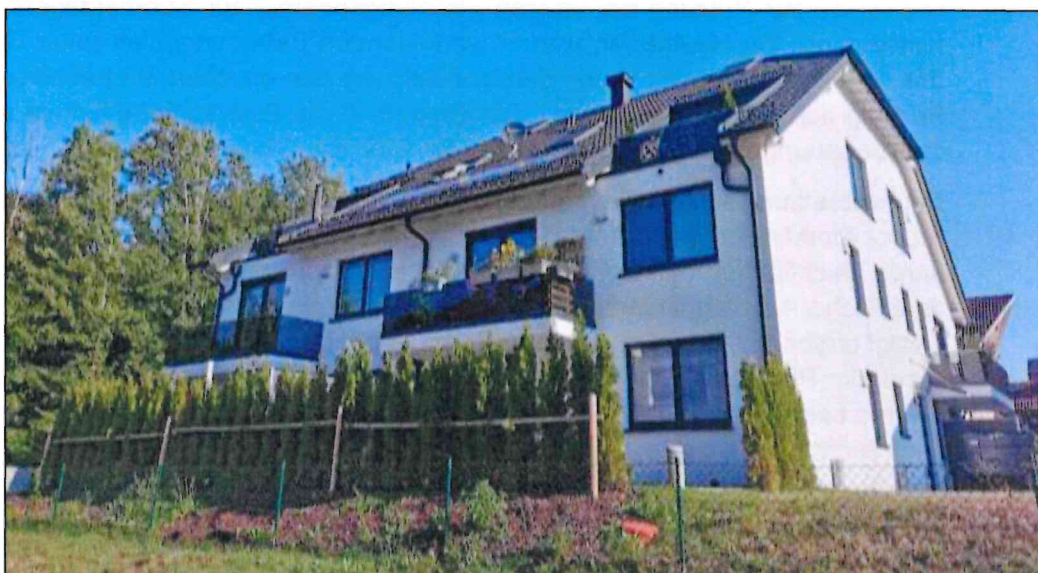
Abb. 21 2019 durch die 11. Änderung des Bebauungsplanes ermöglichtes Mehrfamilienhaus westlich der Bahnhofstraße (WA1) mit städtebaulich verträglich umgesetzten Dacheinschnitten; Quelle: PV; Aufgenommen am 30.07.2020
