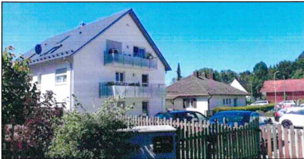
Abb. 6 neues 6-Familienhaus (Birkenweg 2c) mit Satteldach neben eingeschossigem Einfamilienhaus (Bahnhofstraße 127) mit Walmdach; Quelle: PV; Aufgenommen am 30.07.2020
