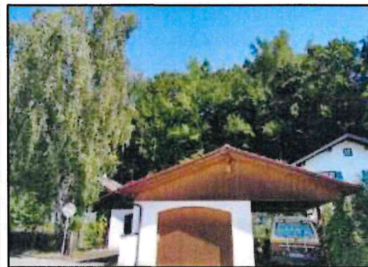
Abb. 15 Häuser nördl. Birkenweg (Quartier 2), Sandbirke an der Straße, Biotop hinter den Häusern auf steilem Gelände; Quelle: PV; Aufgenommen am 30.07.2020
